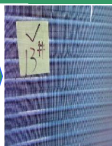
11-4. 室内機熱交換器洗浄前後
