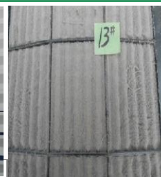
11-4. 室内機熱交換器洗浄前後
